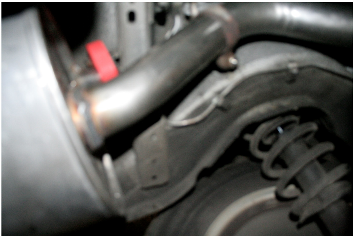
Leider unscharf. Aber dies zeigt das Rohr zwischen ESD und MSD.
